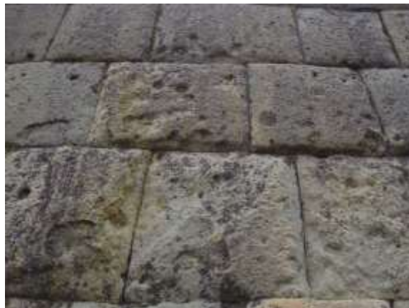
Figura 12. Disgregación de inclusiones
