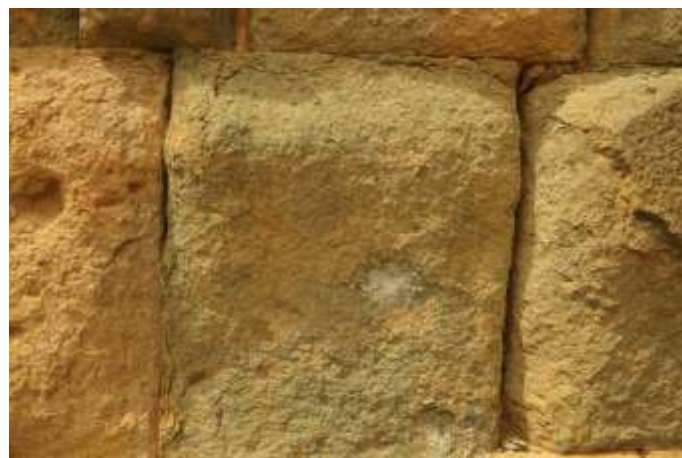
Figura 14. Depósitos de sales solubles e insolubles
