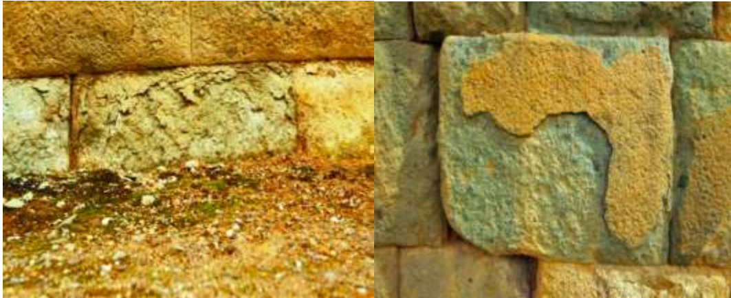
Figura 63. Exfoliación fina (izquierda) y desplazado (derecha)
