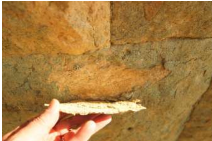
Figura 15. Depósitos de material arcilloso
