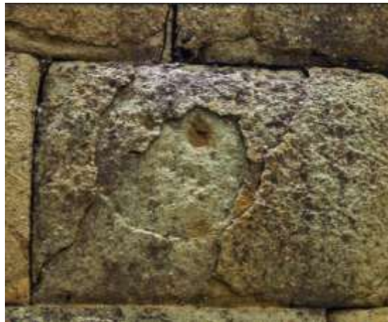
Figura 11. Exfoliación laminar múltiple
