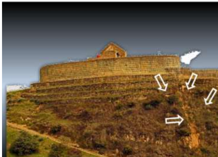
Figura 43. Construcción de 2 columnas de hormigón en 2009 (Swieciochowski, 2014)
